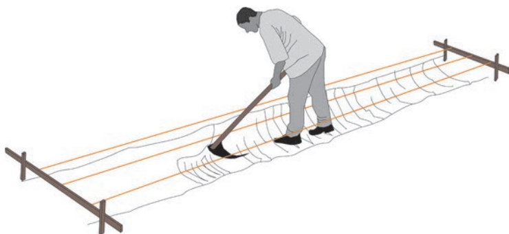
Figura 13 – Preparação da área que servirá de fôrma com leve curvatura, onde serão concretadas as placas.
