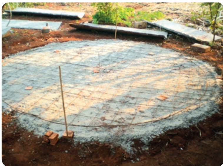
Figura 12 – Preparação da base da cisterna.
