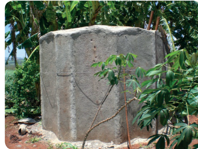
Figura 19 – Protótipo de cisterna executado e finalizado no assentamento pelas famílias participantes do processo de pré-fabricação.
